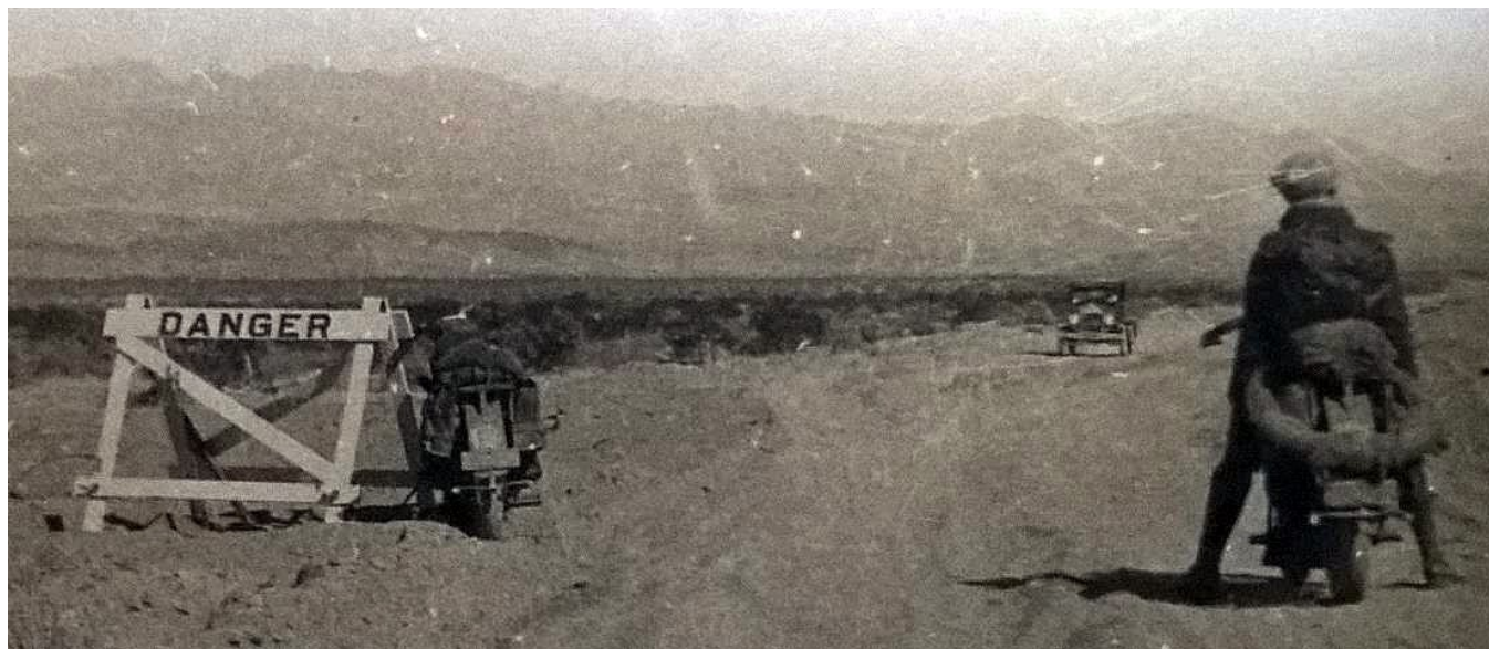
Danger on the Track ! (danger sur la piste) La future route 66 en construction quelque part en Arizona...[coll.part].
