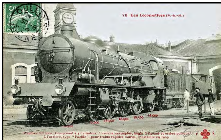
Machine n° 6001 - Compound à 4 cylindres, type "Pacific" pour trains rapides lourds, construite en 1909. 3 essieux accouplés, bogie à l'avant et essieu porteur à l'arrière.
