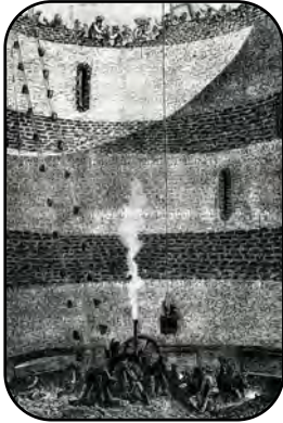
Maçonnerie du puits
