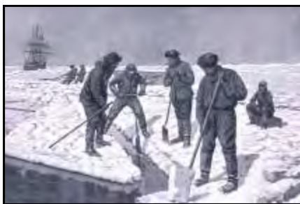
Sciage de la glace pour creuser et ouvrir le canal.
