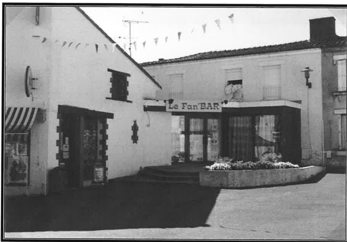
Ancien Bureau de Poste en 2001
