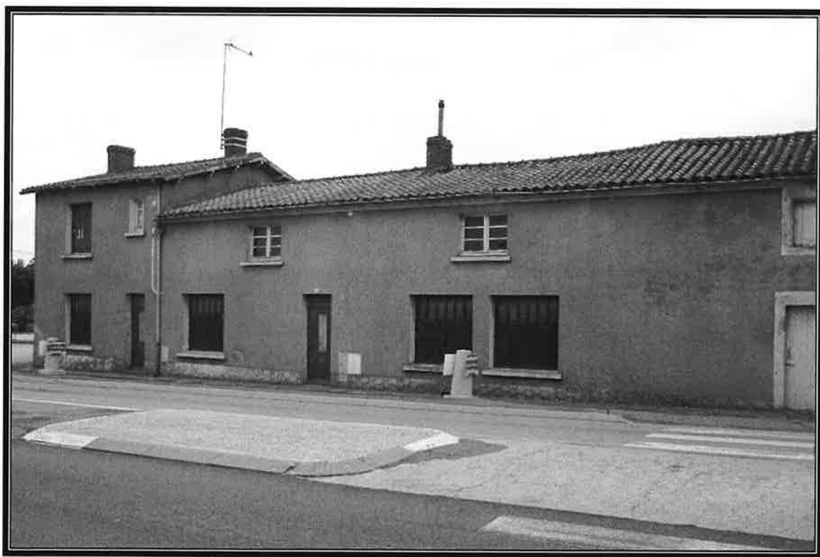
Ancien Bureau de Poste en 2001
